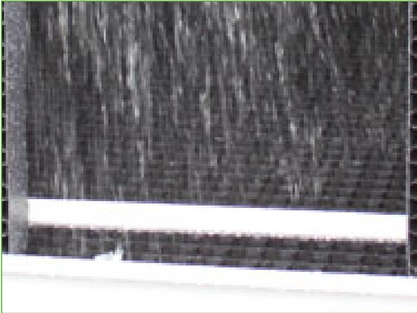
Wasserschalldämpfer im Becken **verringern das Geräusch** des in das Becken fallenden Wassers. Die **Module** sind für die Inspektion oder Reinigung des Beckens problemlos abnehmbar.
