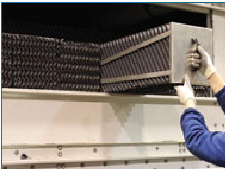
Algunos paquetes de relleno [Versapak](#) cuentan con **tiradores** que facilitan la extracción y la inspección del relleno.
