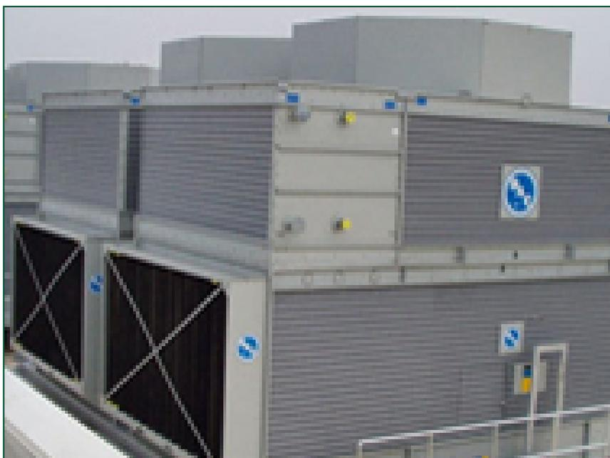
Los condensadores CXV-D emplean **ventiladores axiales silenciosos de bajo consumo**, pero puede reducir aún más el sonido ampliando su condensador CXV-D con [atenuación sonora](#):
