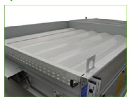
Les registres de fermeture empêchent l'air de circuler à travers l'équipement fermé.
