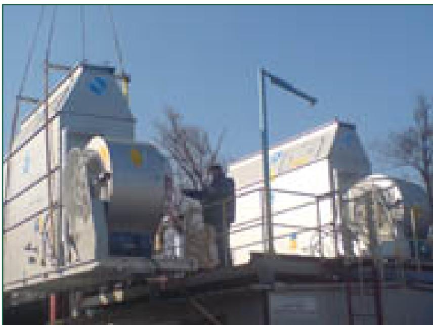
Les hottes au refoulement permettent de se conformer aux prescriptions d'aménagement car elles **surélèvent** le rejet de gaz des installations au-dessus des murs adjacents et augmentent la vitesse de refoulement d'air afin de **réduire le risque de recirculation** dans les espaces confinés.
