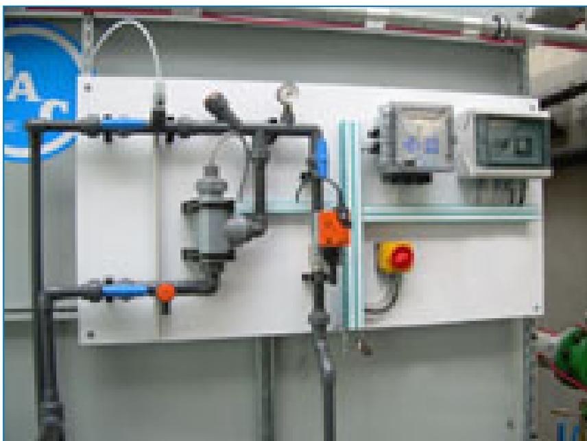
BAC présente une large gamme de **solutions de traitement automatique de l'eau** pour lutter contre la corrosion, l'entartrage, l'encrassement et la prolifération microbologique dans les systèmes de refroidissement intégrant des condenseurs BAC.
