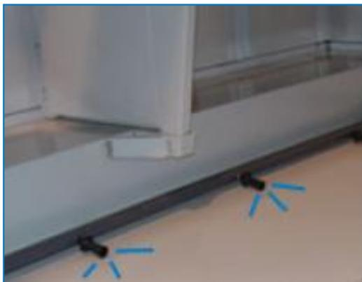
Le système d'injection de bassin **préviend la formation de dépôts dans le bassin d'eau froide** de l'installation. Un système de distribution complet, avec injecteurs, équipe le bassin de la tour **pour raccorder un équipement de filtration dérivée**. [En savoir plus](#)
