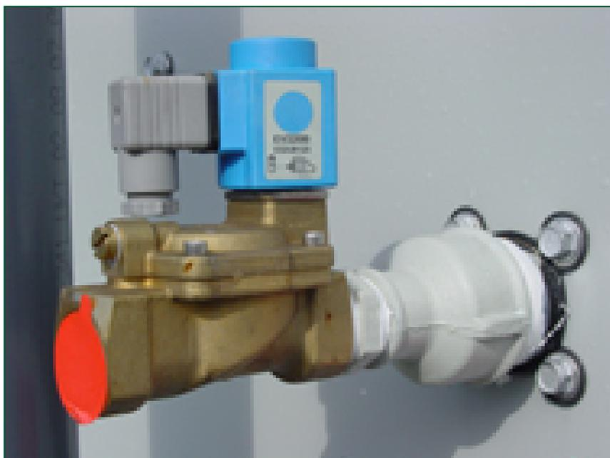
Quando è necessario **un controllo del livello dell'acqua più preciso**, è il momento di sostituire la valvola di reintegro meccanica standard con un dispositivo di controllo elettrico del livello dell'acqua.
