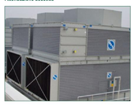
I condensatori CXV-D montano **ventilatori assiali silenziosi e a basso consumo energetico** ma, per ridurre ulteriormente la rumorosità, possono essere integrati mediante un dispositivo di <u>attenuazione acustica</u> .
