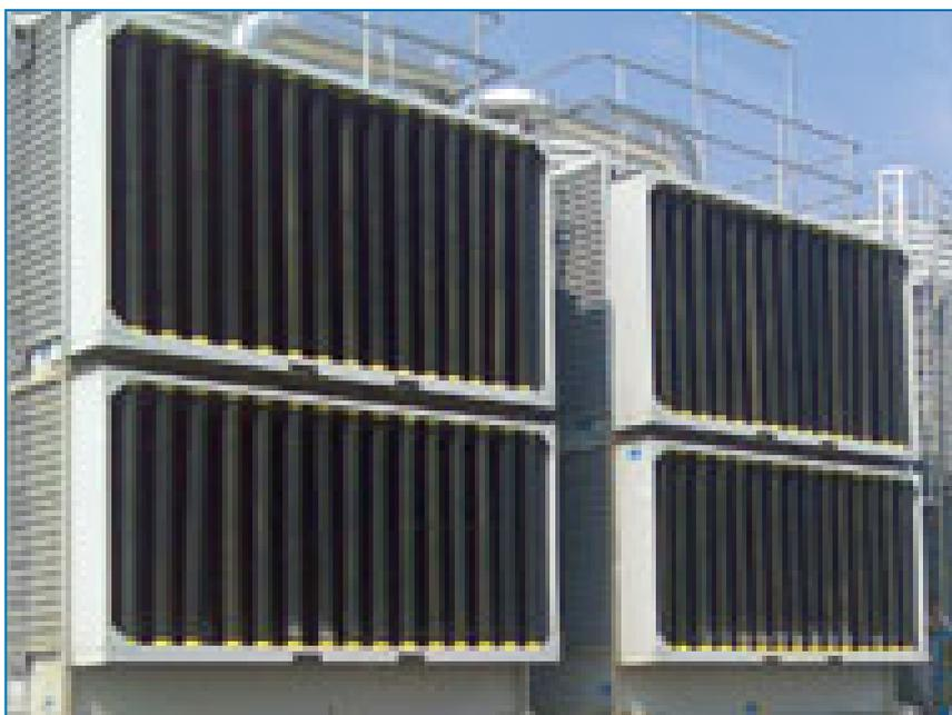
Le torri di raffreddamento S3000E montano **ventilatori assiali silenziosi e a basso consumo energetico** ma, per ridurre ulteriormente la rumorosità, possono essere integrate mediante un dispositivo di [attenuazione acustica](#):
