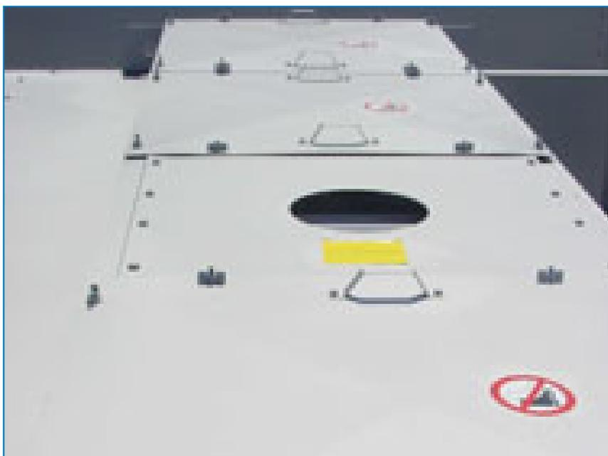
Крышки распределительных бассейнов установок **предотвращают загрязнение воды в бассейне за счет** мусора и др.
