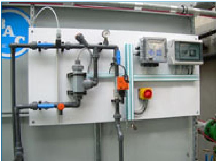
BAC предлагает широкий выбор **комплектов для автоматической обработки воды** для контроля коррозии, известкового налета, запахов и размножения микроорганизмов в системах охлаждения, включающих градирни BAC.
