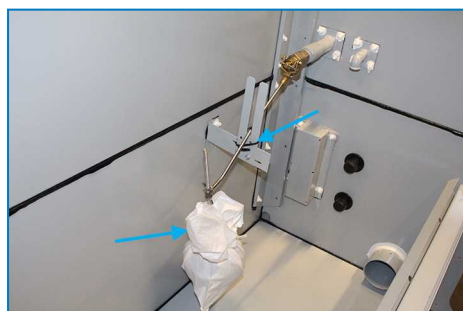
Upevnění a zabalení kulového plováku
