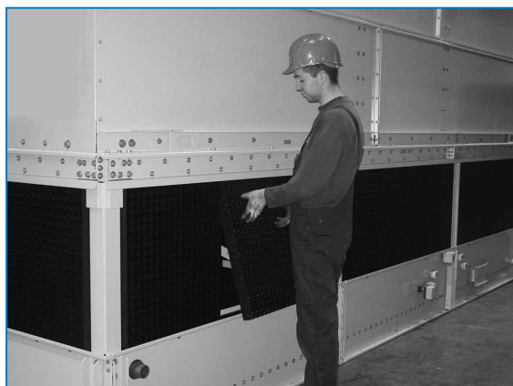
Снятие комбинированных щитов на входе
