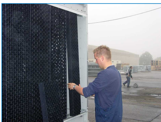
Demontáž kombinovaných krytů sání vzduchu
