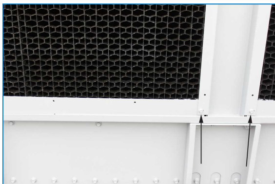
Demontáž přepravních pásů
