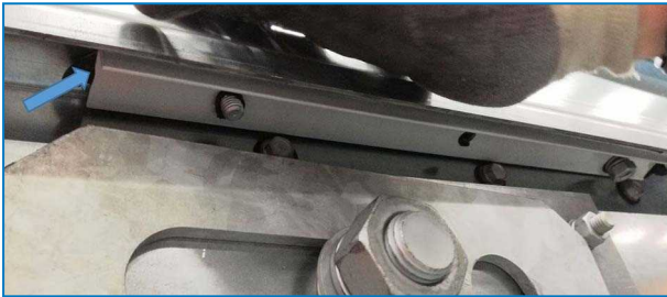
Установленный уплотнительный профиль
