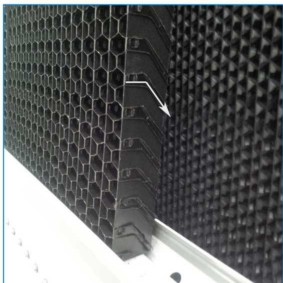
Ориентация комбинированных экранов на входе
