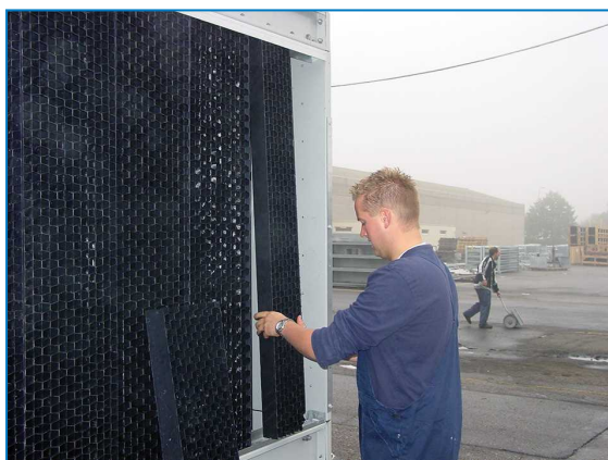
Снятие комбинированных щитов на входе
