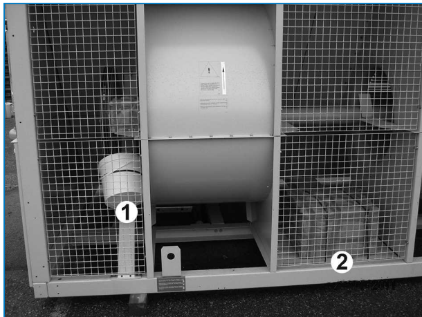
A szerelési anyagok és a szivattyú elhelyezkedése
