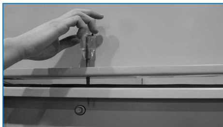
Csavarlyukak igazítása lyukasztótűskék segítségével
