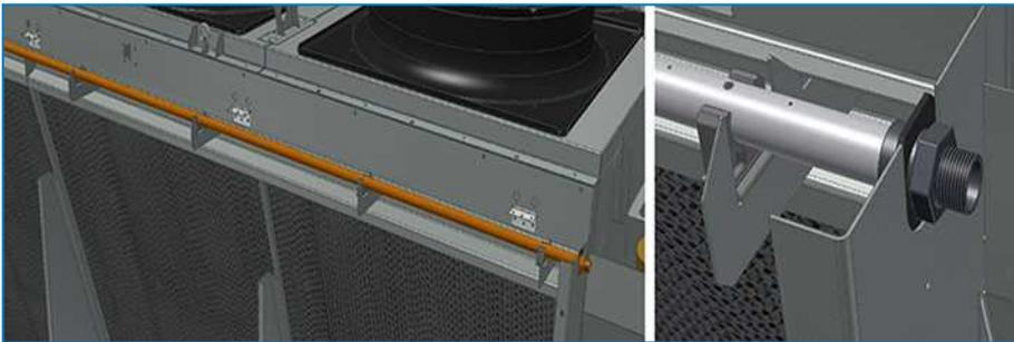
8. Aplique cinta PTFE a la conexión roscada y atornille la tubería al conjunto de la tubería de suministro, inserte el solenoide en la válvula.
