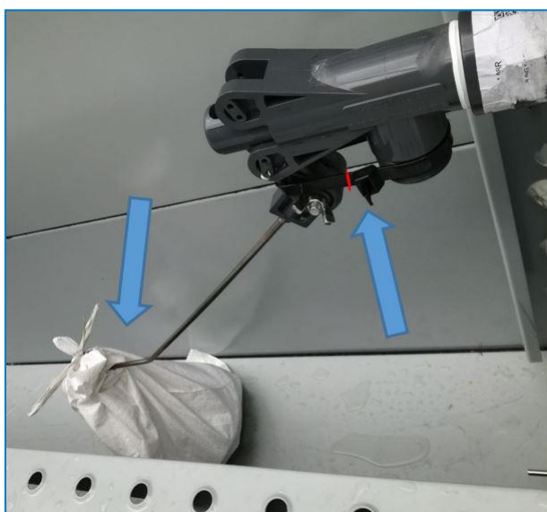
Montaż i owijanie kuli pływaka
