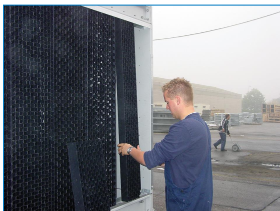
Usuwanie zespolonych osłon wlotowych
