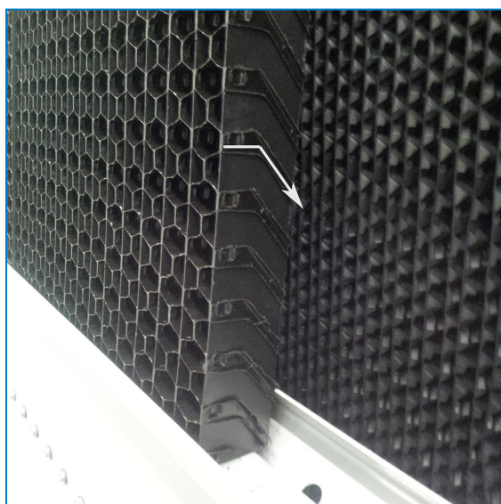
Orientacja zespolonej osłony wylotowej
