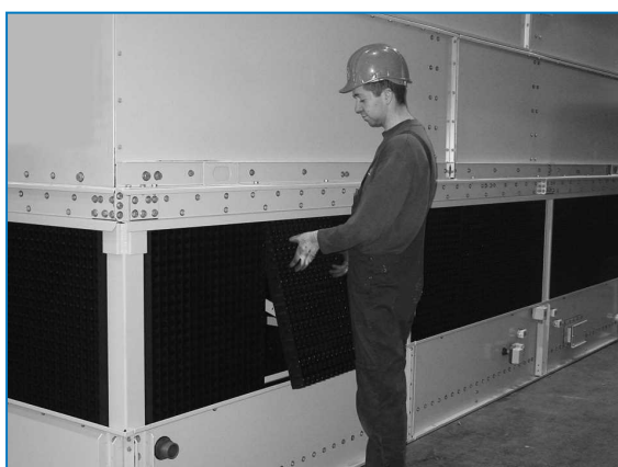
Usuwanie zespolonych osłon wlotowych
