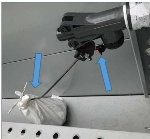
Montaż i owijanie kuli pływaka
