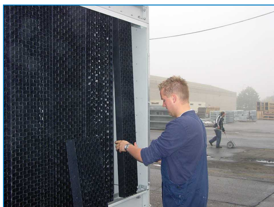
Usuwanie zespolonych osłon wlotowych
