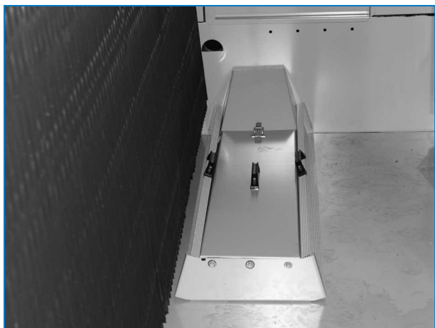
Misa wody zimnej i sito misy
