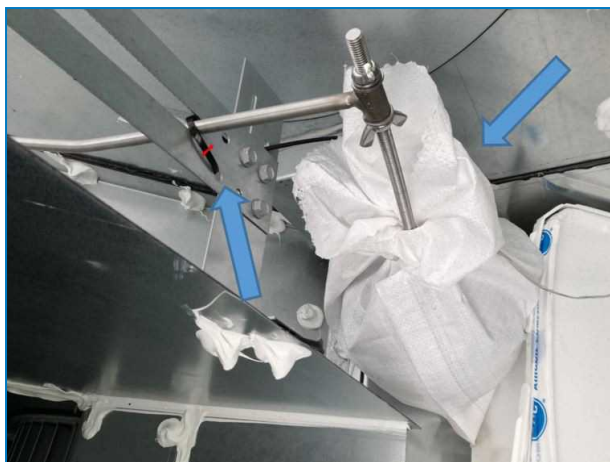
Montaż i owijanie kuli pływaka
