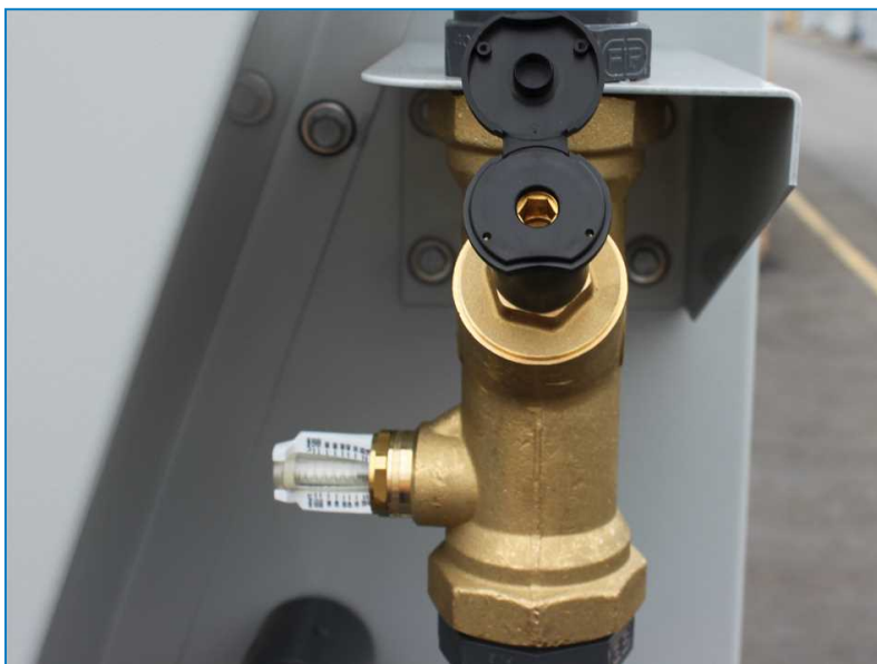
Vis de réglage du débit d'eau
