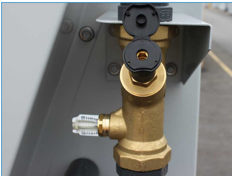
Vis de réglage du débit d'eau
