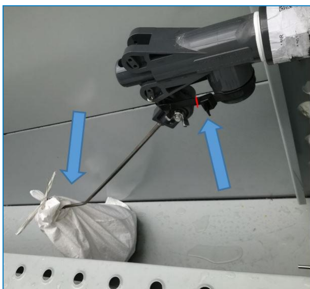
Fijación y envoltura del flotador de bola
