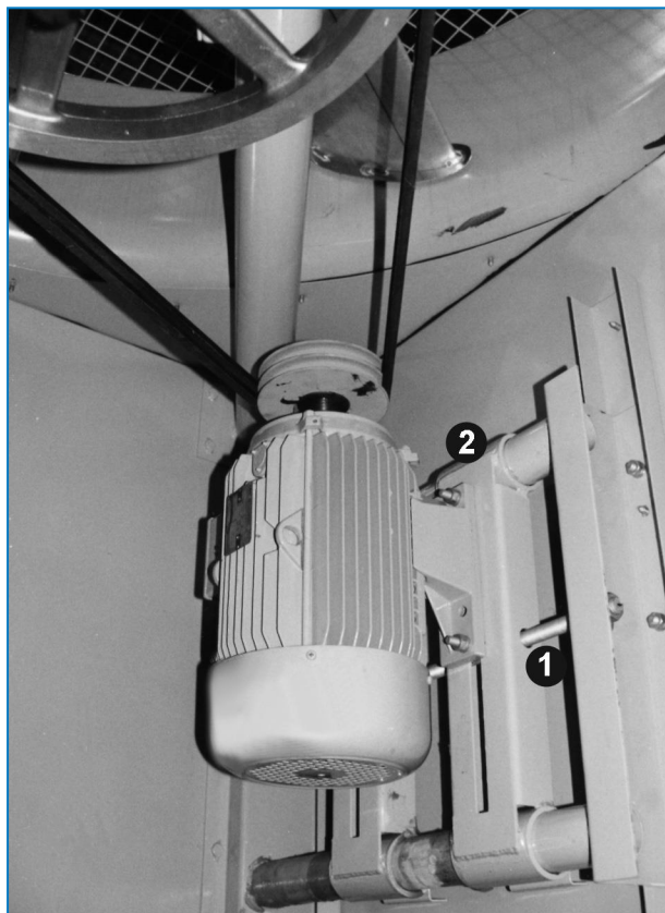
Base do motor ajustável
