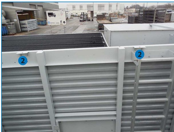
2. Monteringsguide/fäste för nedre sektion
