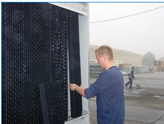
Uklonite kombinovane zaštitne rešetke ulaznog otvora
