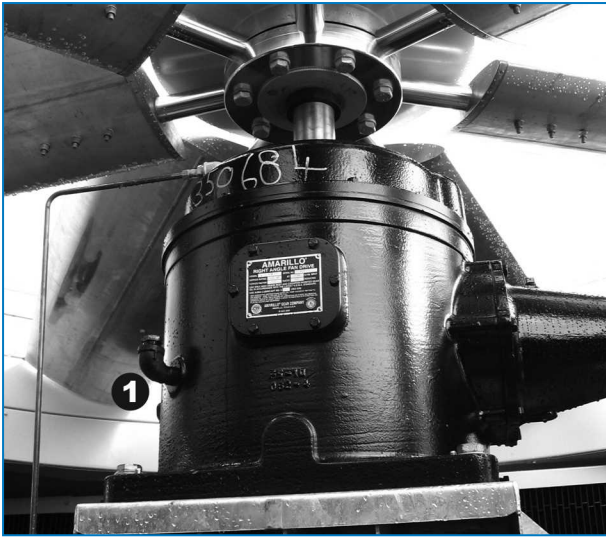
Tandwielaandrijving met enkelvoudige overbrenging
