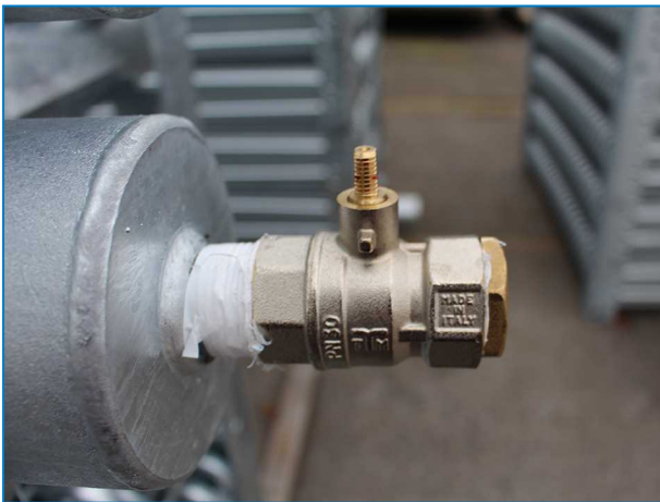
Bovenste batterijaansluiting met drukaflaatklep op condensors.
