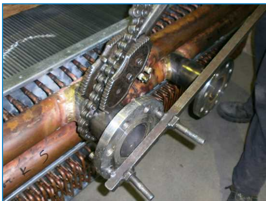
Installeren van schroefflens
