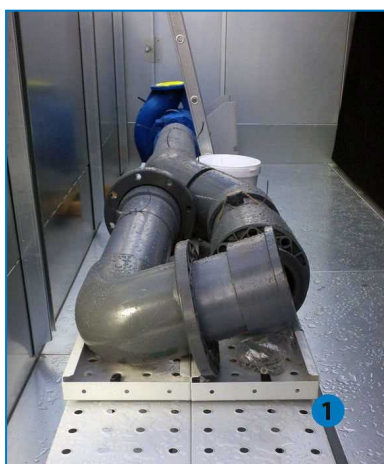
1. Uklonite pumpu i cevi iz bazena.
