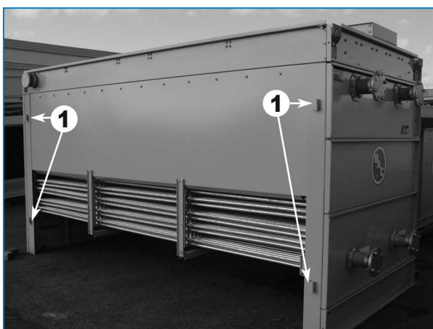
Męskie prowadnice montażowe sekcji wężownicy
