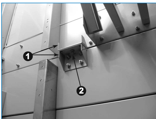
Komora wyrównawcza zamontowana do dolnej sekcji
