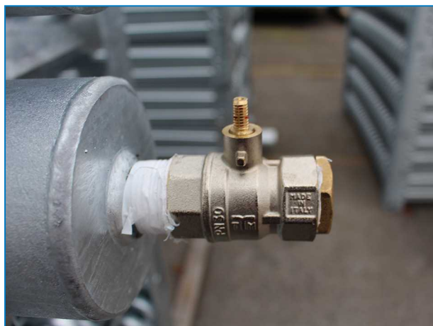
Górne złącze węzownicy z zaworem nadmiarowym na wieżach chłodniczych z obiegiem zamkniętym w przypadku złączy większych niż ND100.
