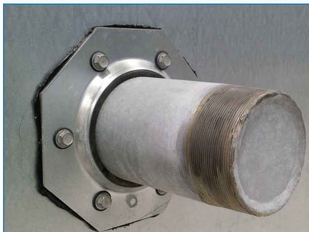
Dolne zamknięte złącze węzownicy (na wieżach chłodniczych z obiegiem zamkniętym w przypadku złączy o rozmiarach do ND100).
