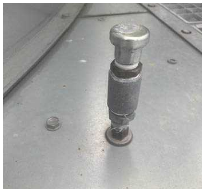
Airbreather on fan deck
