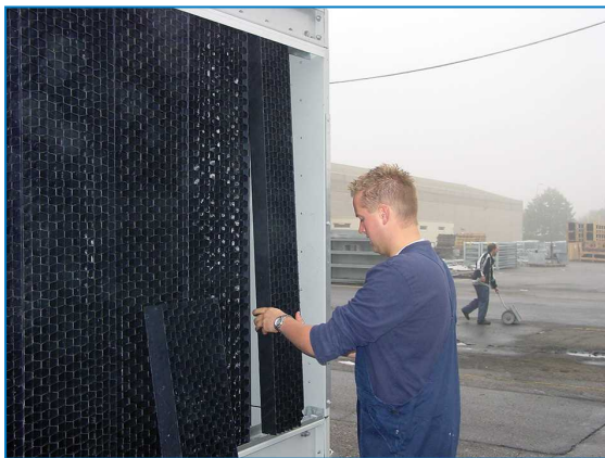
Odstranjevanje kombiniranih pokrovov dovodov
