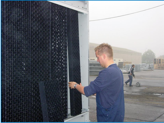
Kombinierte Lufteintrittsschutzelemente entfernen
