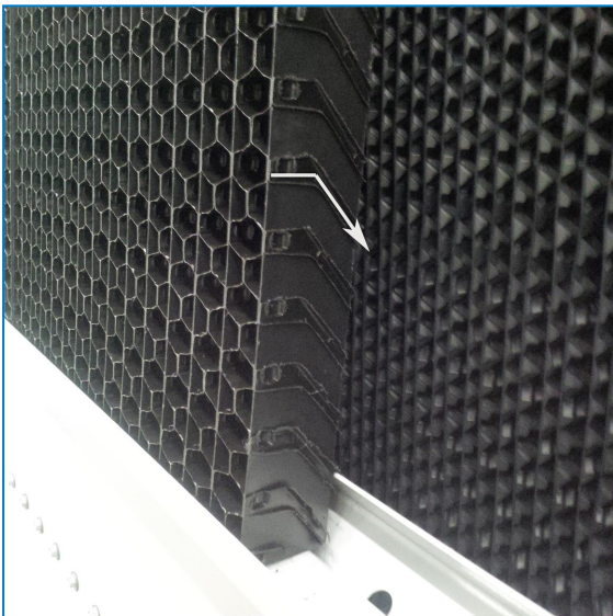
Ausrichtung des Lufteintrittsschutzelements
