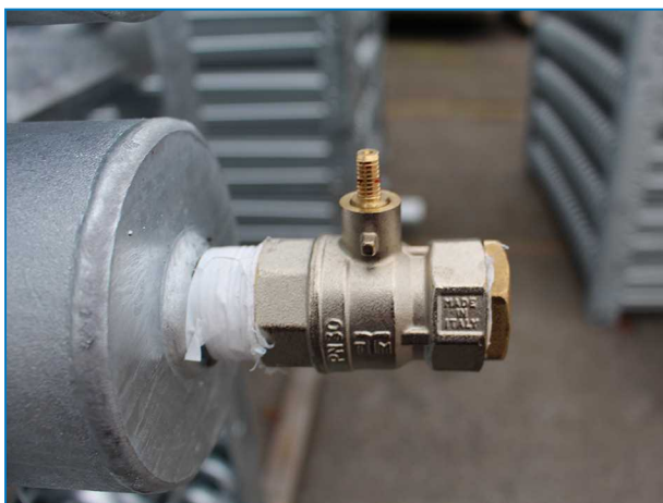
Horné spojenie výmenníka s uvoľňovacím ventilom tlaku na chladiacich vežiach s uzavretým okruhom s pripojením väčším ako ND100.
